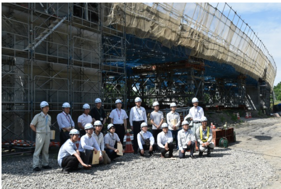
巨大な橋梁建設現場
