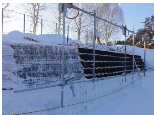
大学構内に構築した補強土壁
